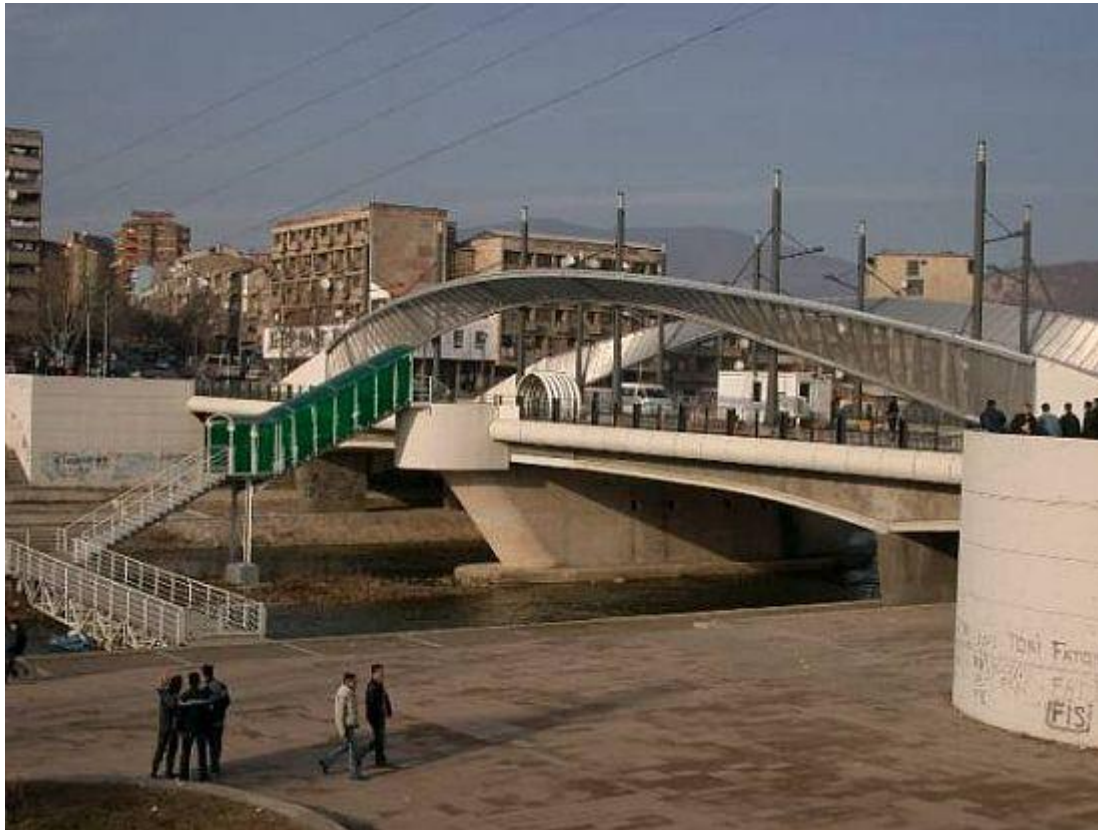
Figure n°2 : Le pont Ouest de Mitrovica
